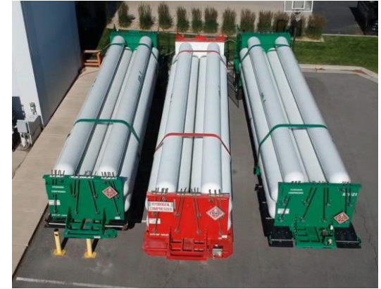
Waterstof brandstofcellen ten behoeve van de back-up van een datacenter in Salt Lake City (Microsoft)
